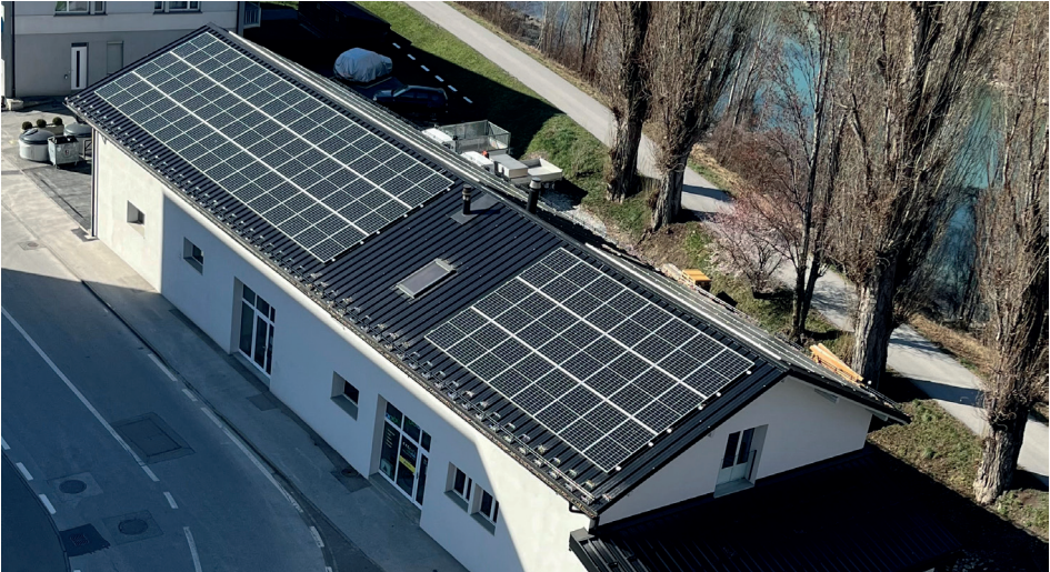
Les panneaux solaires ont été posés sur l’ensemble de la toiture. © Guy Jacquemet
